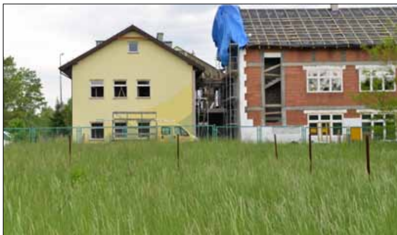
W trakcie prac
