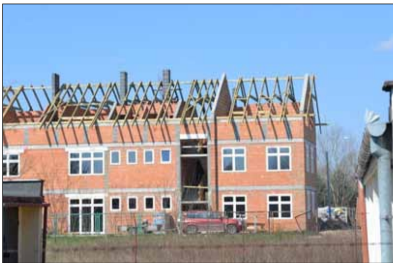
W trakcie prac
